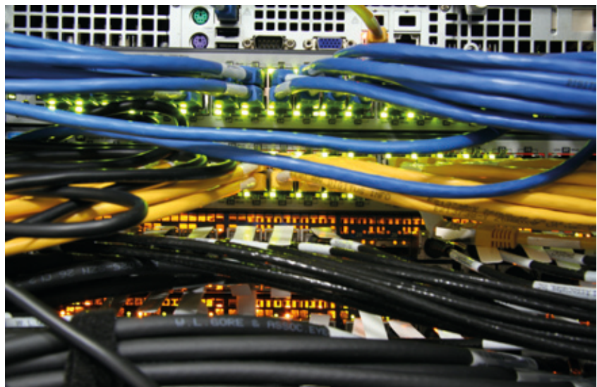
3 Cluster-Verkabelung (blau: Service-Netzwerk, gelb: 1 Gbit/s-Ethernet, schwarz: Infiniband)
